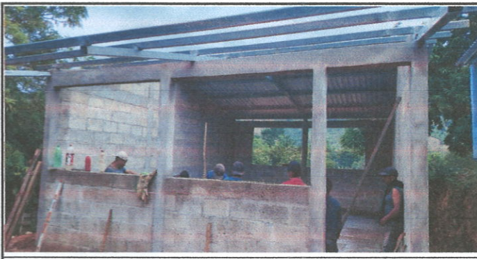
Foto 5: Instalación de estructura de techo y cubierta de láminas en módulo tipo pórtico calibre 26
