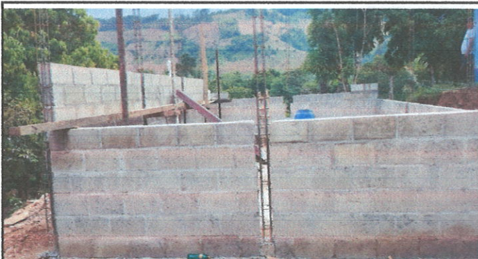
Foto 4: Instalación de pared en módulo tipo pórtico
