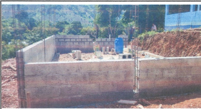
Foto 3: Instalación de pared en módulo tipo pórtico
