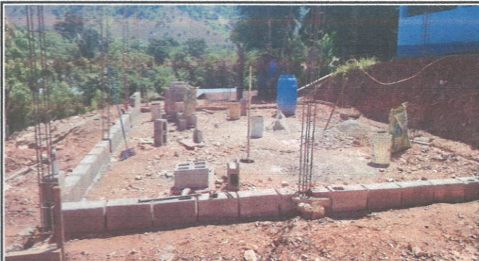
Foto1: Instalación de cimiento corrido de block
